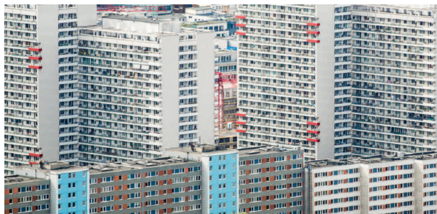
Berlin, Plattenbau -construction à partir d'éléments préfabriqués en béton © Michael Haussmann
