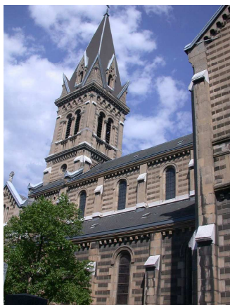
Figure 1 : Eglise Saint-Bruno, bâtie en pierres factices à base de ciment naturel. (1874 – Grenoble, France).
